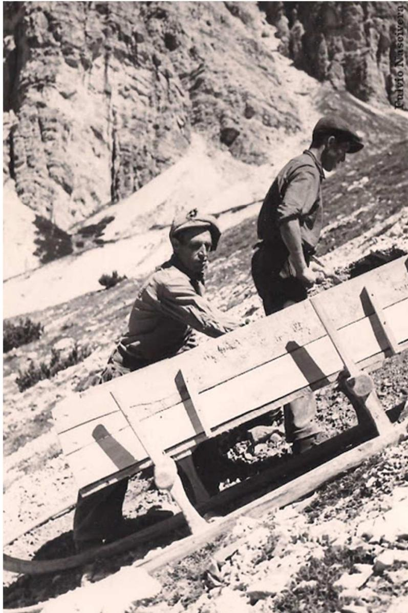
Il Problema maggiore consisteva nel trasferimento a monte di pezzi molto pesanti e ingombranti (motori, riduttori, ruote motrici dal peso di 1200-1400Kg ecc.). Per questo venne montata una teleferica; ma lo stesso trasporto dell'argano alla forcella a monte, con le sole forze umane fu un'impresa ardita lungo il canalone ghiaioso di 900 metri.
